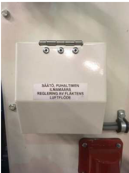
Puhallin, nopeussäätö (kannen alla) sekä 16 A kojejavastake syötölle (punainen)
